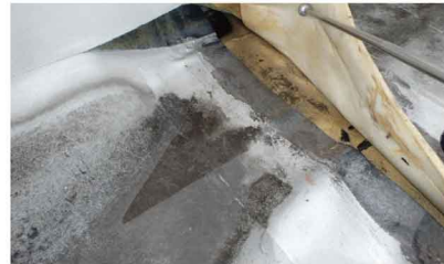
シート防水の劣化による剥離が発生しています。
